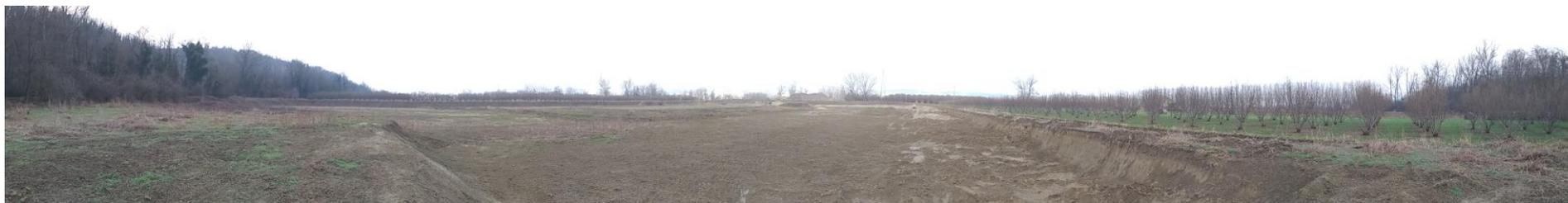
Foto 1 – Vista dell'area di cava in corso di coltivazione. Il punto di presa è posto nella fascia di rispetto del canale di San Marzano. Centralmente si vede il settore 1 che risulta già coltivato e parzialmente riprofilato secondo le quote di progetto. Sullo sfondo si intravede il settore 2 in corso di coltivazione. A destra si pone il settore proposto in ampliamento.
