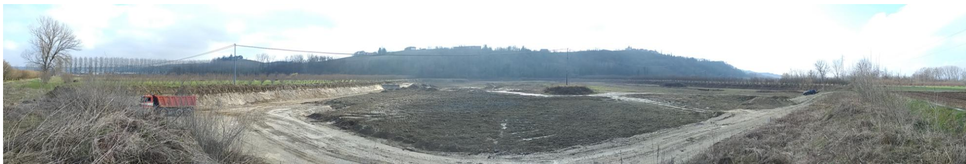
Foto 2 – Vista dell'area di cava “Capitto 4” dal suo estremo nord-ovest. A sinistra si vede il settore in corso di coltivazione. In primo piano la rampa di accesso al fronte di cava che sarà l'ultima porzione oggetto di estrazione. A destra si vede invece la porzione di cava già coltivata e nella quale il terreno è già stato parzialmente riprofilato secondo le previsioni progettuali.
